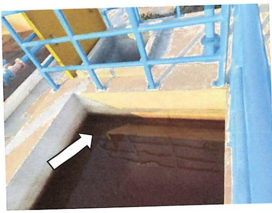
**Imagen 07:** Salida de agua tratada en cámara de sedimentación de lodos
