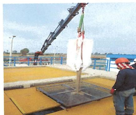
**Imagen 01:** Llenado de agua a filtro Dynasand (1a), Llenado de arena a filtros Dynasand (1b),
