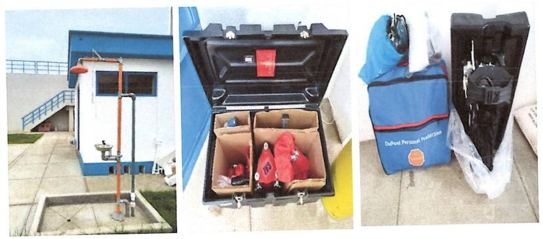
*Imagen 03: Equipos de emergencia para la sala de cloración*
