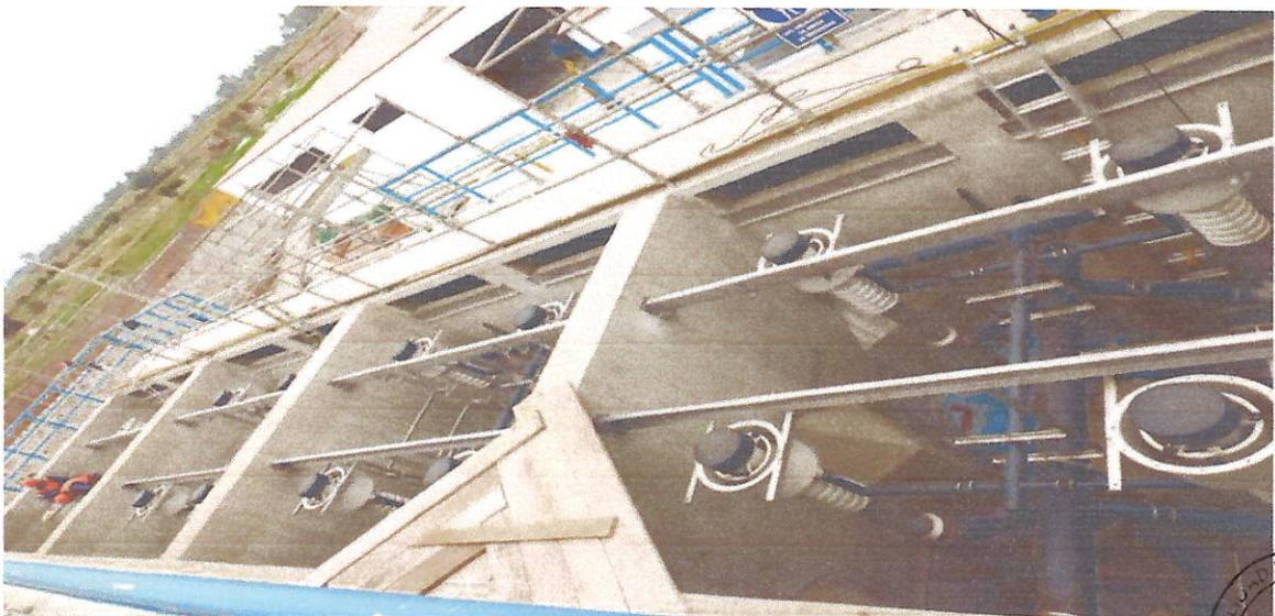
Imagen 9: Filtros Dynasand en estructura de concreto
