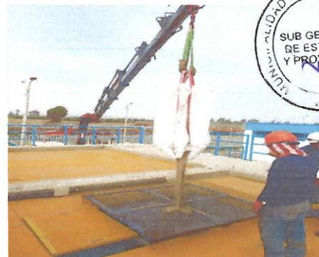
**Imagen 37:** Llenado de agua a filtro Dynasand (1a), Llenado de arena a filtros Dynasand (1b).
