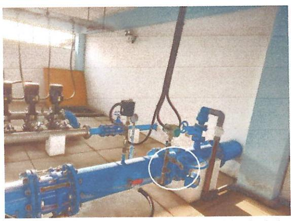
Imagen 41: Toma de muestra de efluente tubería de impulsión a reservorio R1
