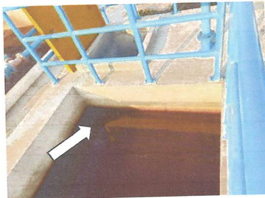
*Imagen 43: Salida de agua tratada en cámara de sedimentación de lodos*
