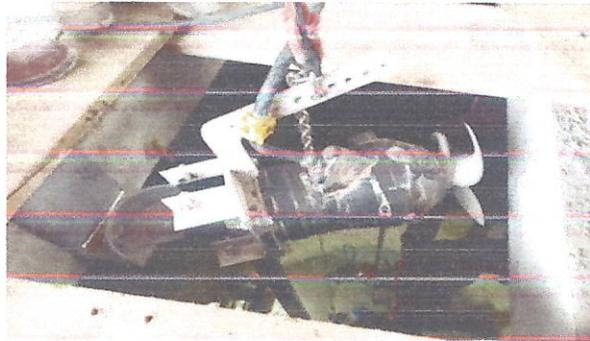
Imagen 2: Agitador ingresando por la barra guía a cámara húmeda
